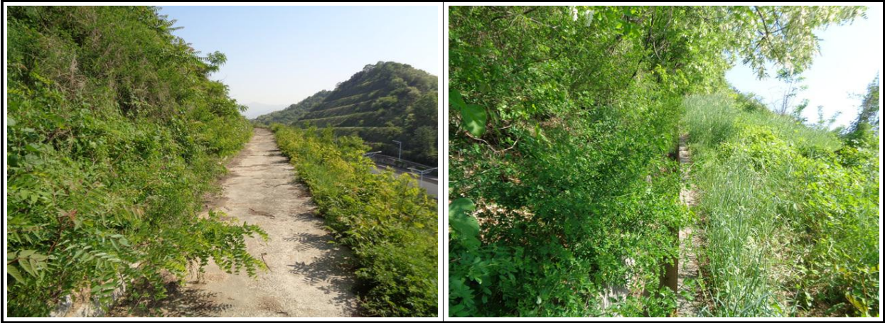
【그림 1.3.3】배수시설 전경
